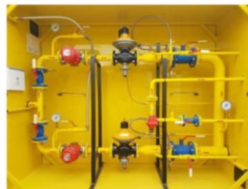
ГРПШ-МОДУЛЬ-А50-2030-У1, оснащенный фильтрами газа РЕД-50.
